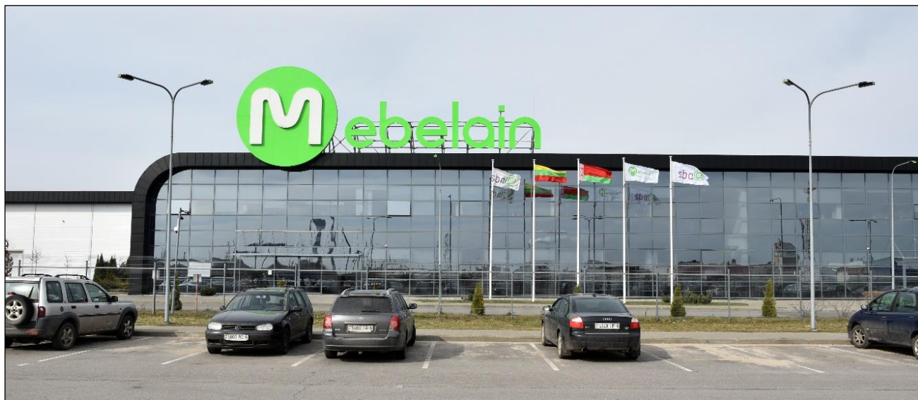
Рисунок 2.7 – Производственный корпус ИООО «Мебелаин»
